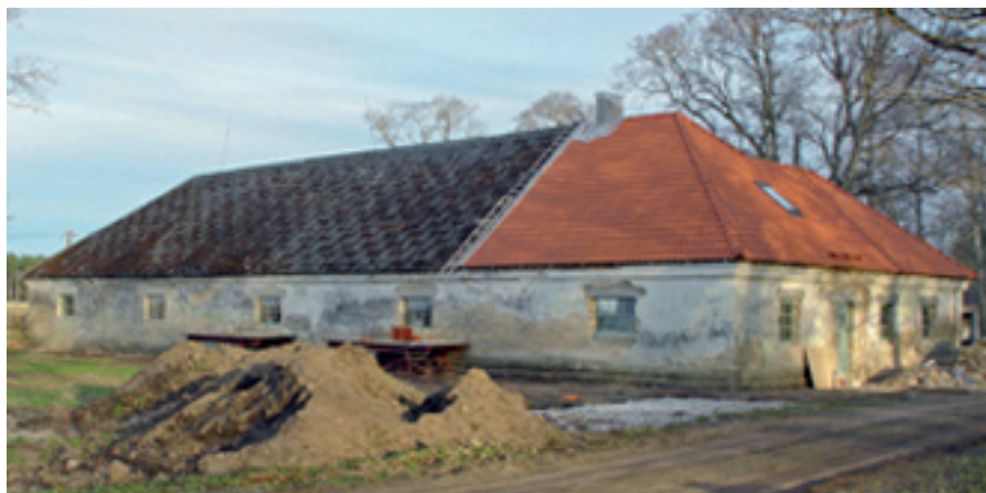
Ein alter Kornspeicher von Paddas wird ausgebaut
